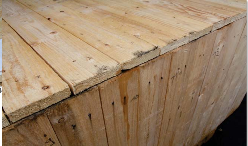
Kistendeckels A mit seitlich ablaufendem Wasser
